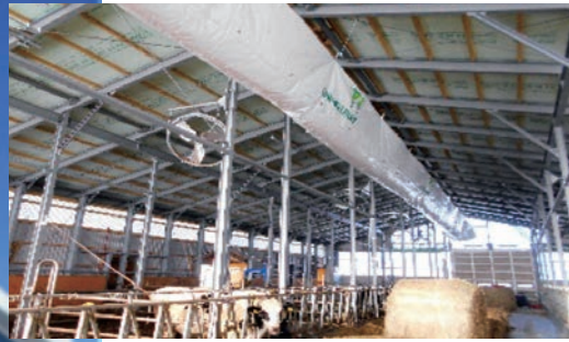
育成舎・フリーストール 等の陽圧換気・内部工事 内部工事
