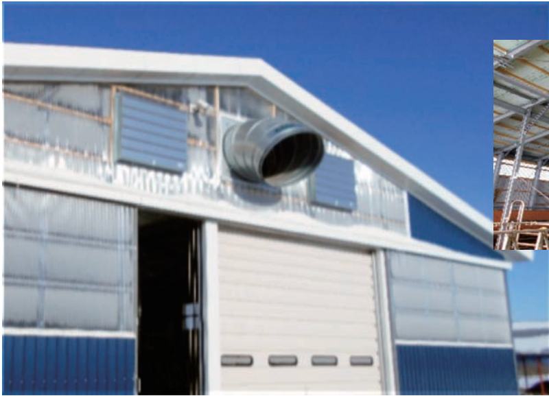
育成舎・フリーストール 等の陽圧換気・内部工事 内部工事
