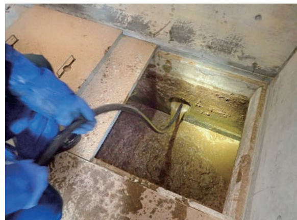
排水管の詰りの清掃
