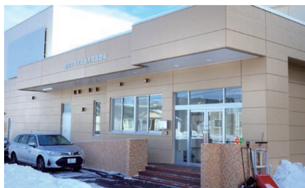
▲標茶中央学校給食共同調理場改築附帯空調暖房設備工事
