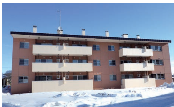
▲川上団地町営住宅附帯機械設備工事
