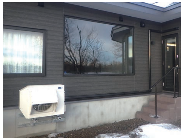
▲エアコン工事
