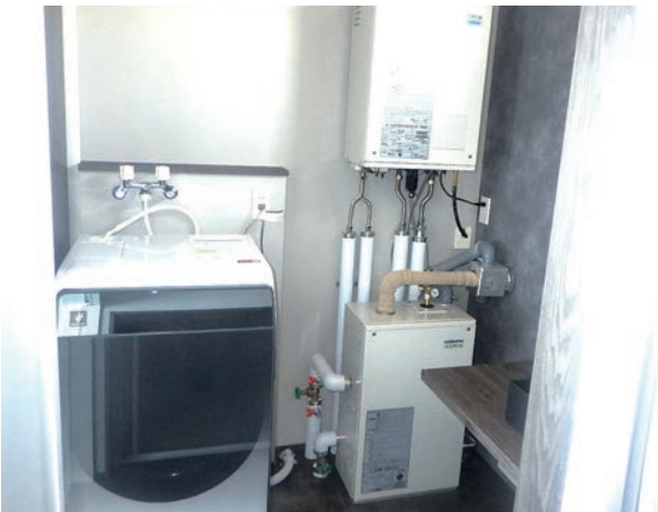
▲住宅設備工事
