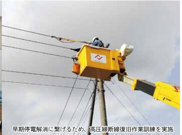
早期停電解消に繋げるため、高圧線断線復旧作業訓練を実施
